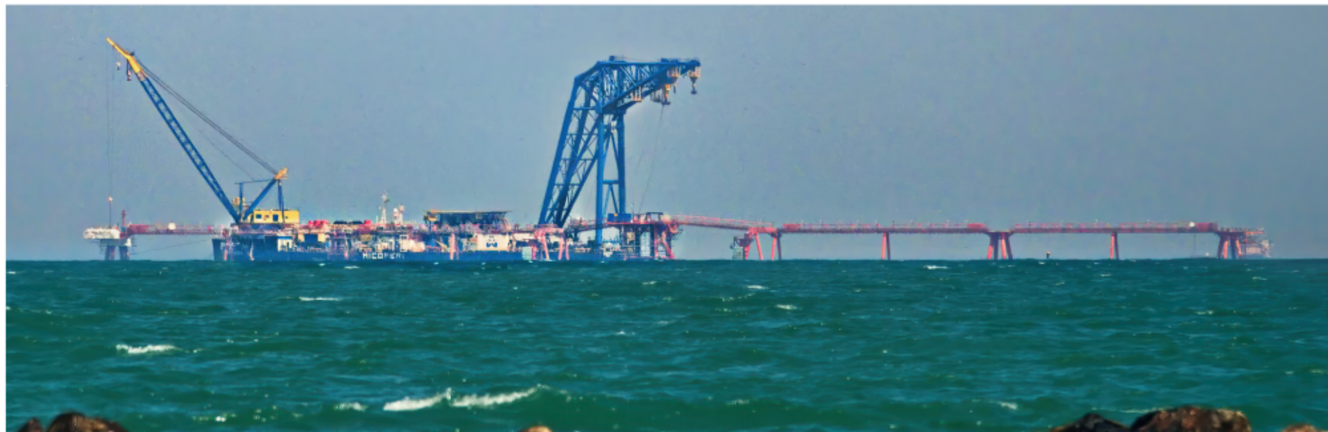
I lavori in corso al largo di Punta Marina, sotto la nave Singapore FOTO FIORENTINI
